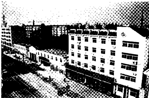
江浦县国土管理局综合办公楼
