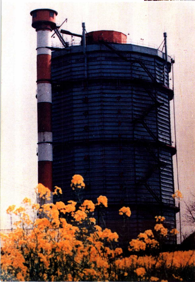
苏州钢铁厂煤气柜。
