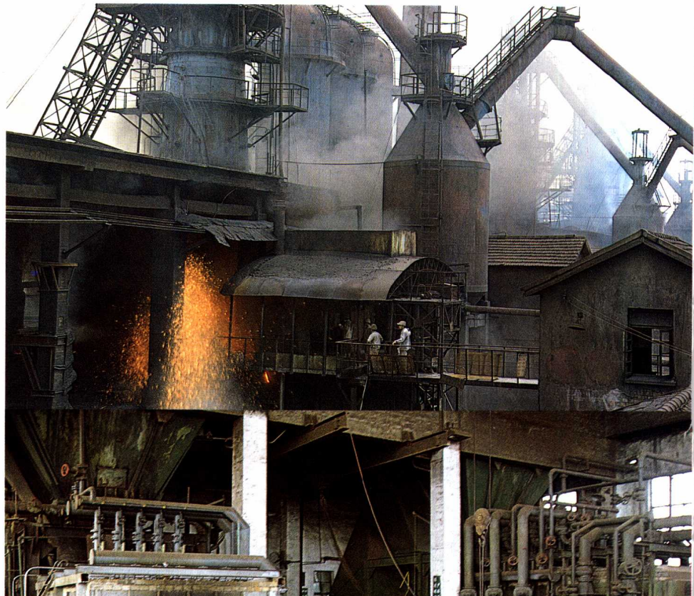
苏州钢铁厂 94 立方米高炉。
