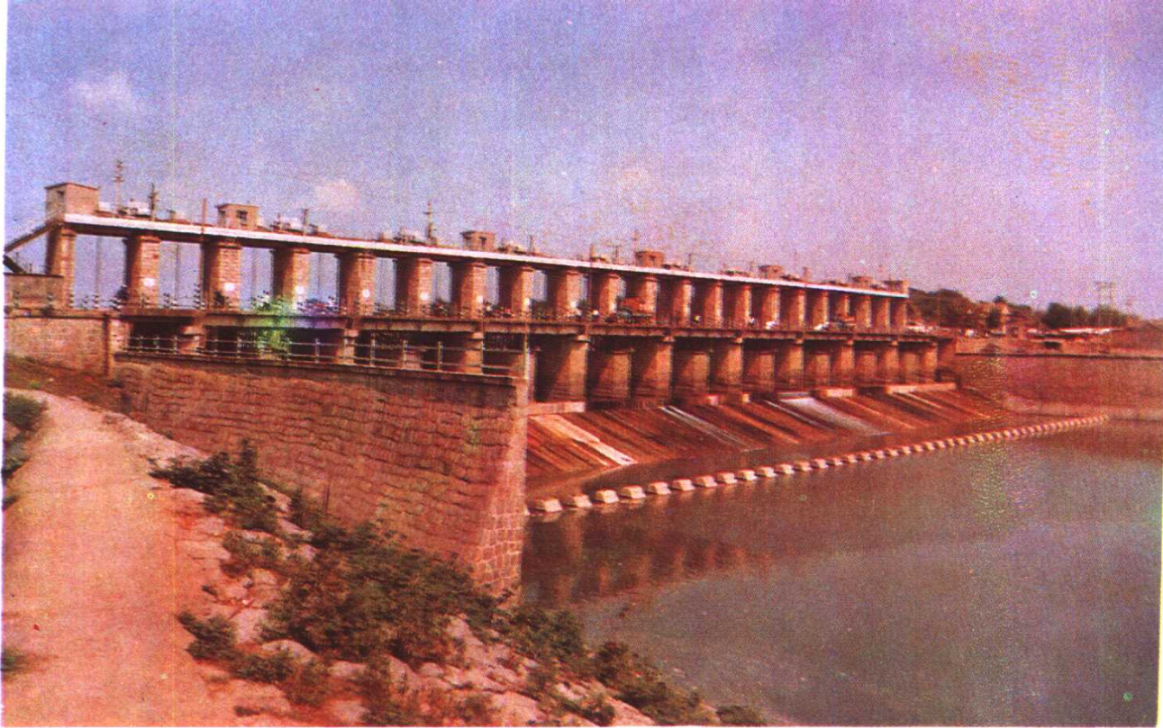
◁ 蒙城县涡河分洪闸
