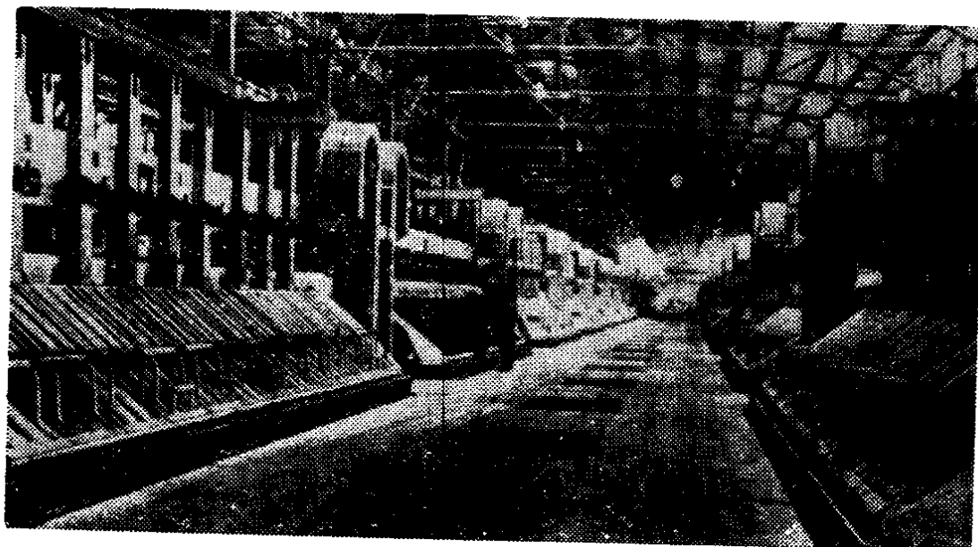
图 1-2 电解槽系列的照片
