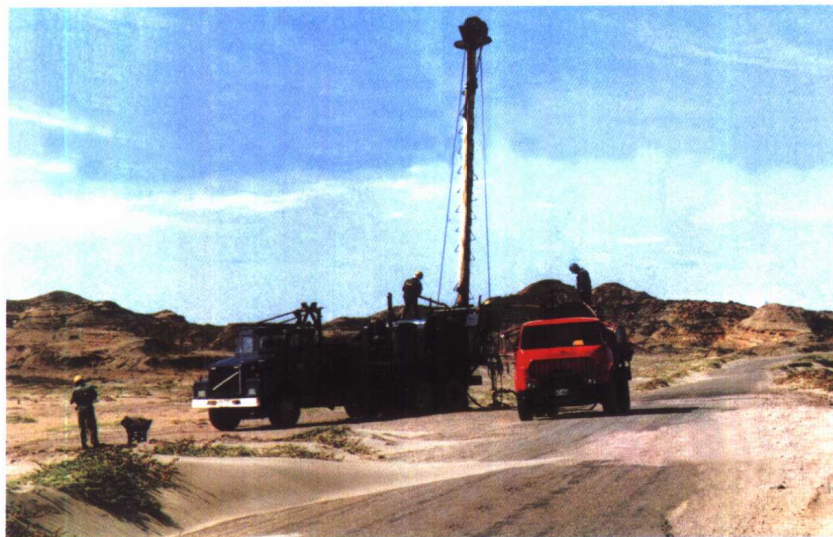
秘鲁石油项目是中国石油天然气集团公司第一个海外油田开发项目，这是油田第七作业区的生产场面
