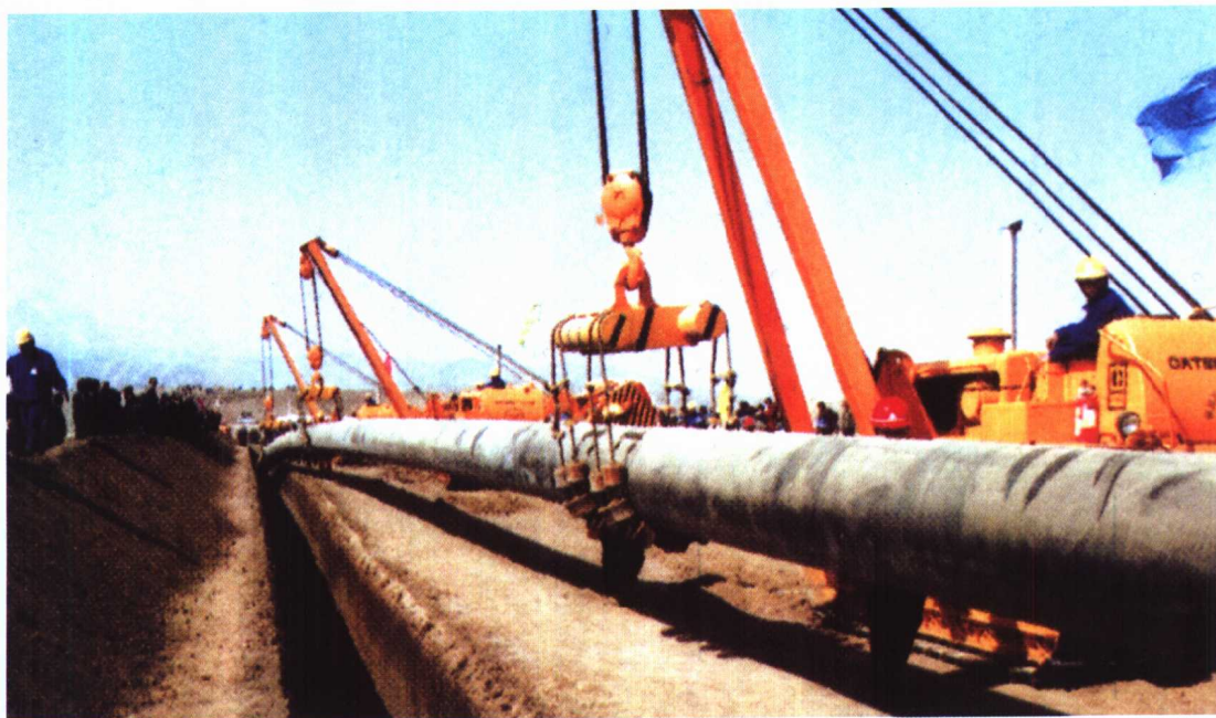
涩宁兰输气管道建设工程是国家确定的2000年西部大开发十大重点工程之一，图为施工中的涩宁兰输气管道工程
