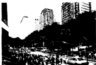
兴建中的新国乌节路易安城
