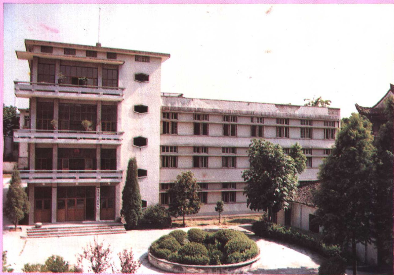
旌德县人民政府办公楼
