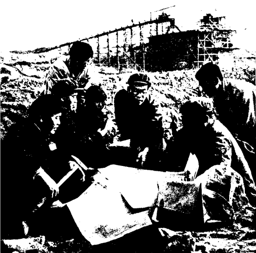
工人、干部、技术人员 在现场研究施工方案。
