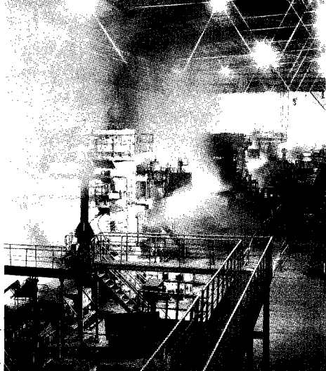
米七热电站生产线
