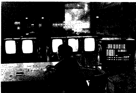
采用工业电视对生产过程进行监视
