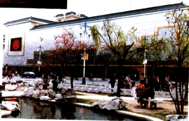
中国工商银行扬州市支行办公营业楼
