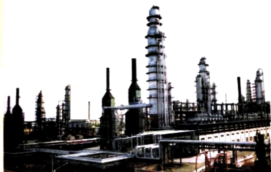
在旧常压基础上已建起年加工能力达到 600 万吨的三套常减压装置。
