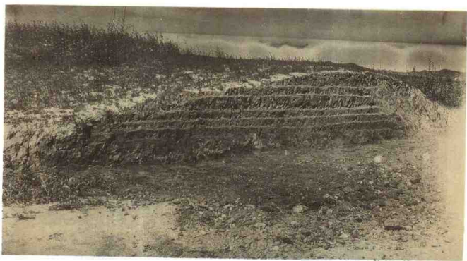
建平县小五家土城夯土墙，夯层厚度为12—28厘米。 项春松摄影
