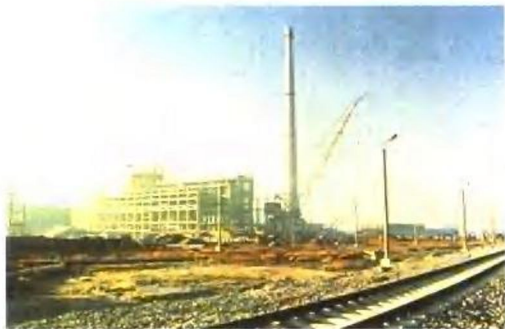
右上 福马公路鼓山隧道是目前 中国最长的双线公路隧道 左上 建设中的铁路 左中 湖北枣阳石台寺渡槽吊装 下 西藏高原公路 孔繁森 摄
