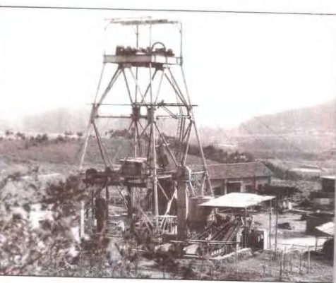
● 安庆铜矿主井下掘现场
