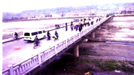
7. 中源河胜利大桥
