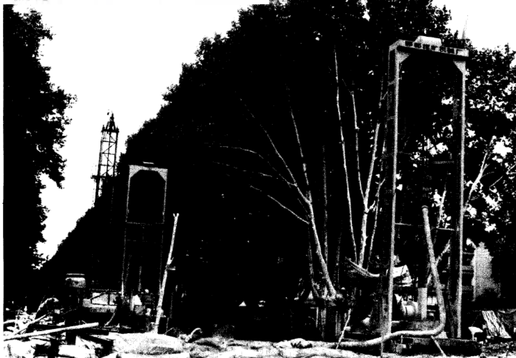
水文地质局 GPF118 桩基钻机（正、反循环）和 GPS115 桩基钻机 （正、反循环）施工灌注扩底桩，直径可达到 2 米以上。图为他们正在 马头电厂施工
