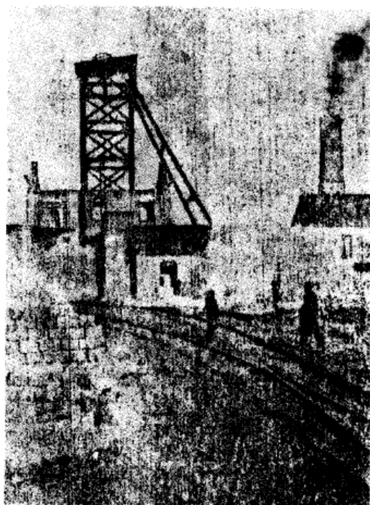
始建于1906年井陘煤 矿南竖井
