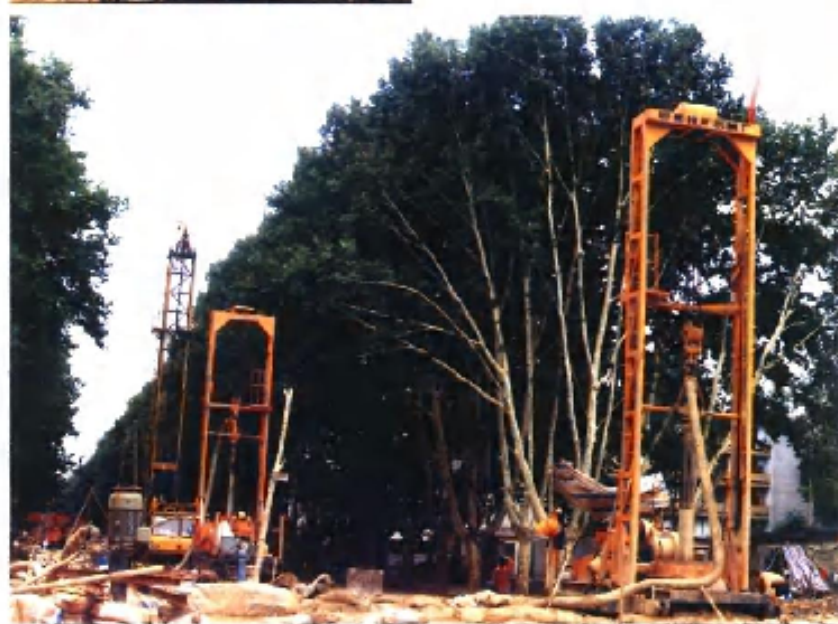
水文地质局 GPF118 桩基钻机（正、反循环）和 GPS115 桩基钻机 （正、反循环）施工灌注扩底桩，直径可达到 2 米以上。图为他们正在 马头电厂施工
