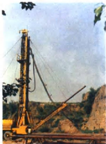
水文地质局从法国引进的 H—28 型全液压车装水井钻 机，在太行山区施工
