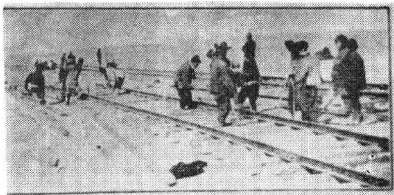
洮索铁路铺轨情形
