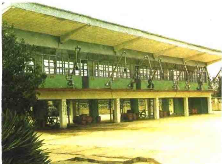
金华古方油库发油台
