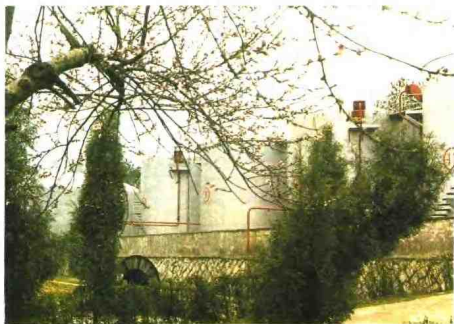
金华古方油库储油罐区
