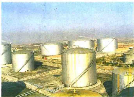
宁波五阳油库轻油储罐区
