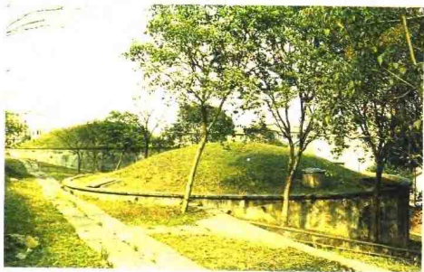
萧山县石油公司“土油罐”
