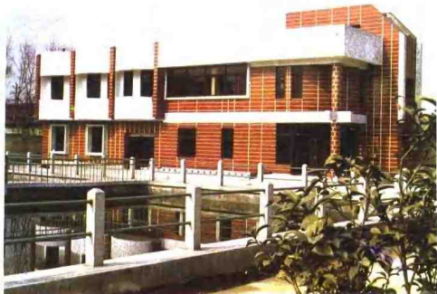
杭州小河油库消防泵房
