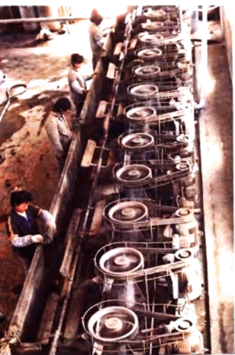
凤县黄牛咀铅锌选矿 厂选矿车间俯瞰。
