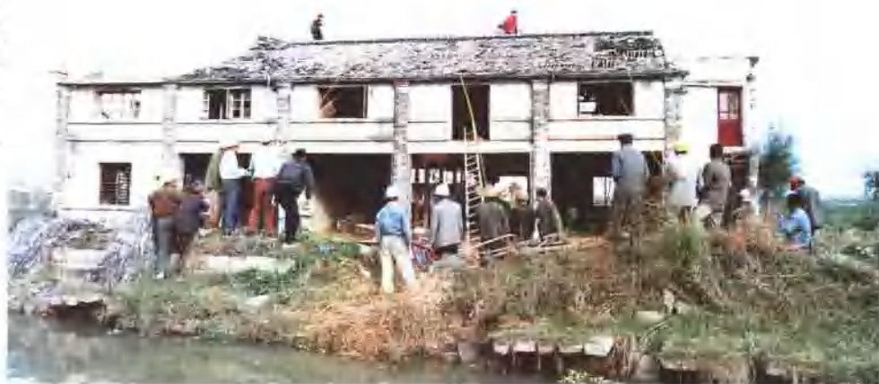
瓯海区拆房还田场景
