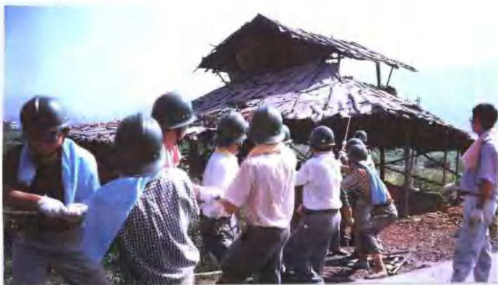
图为瓯海土地管理分局领导和干部拆除违法占地建筑物
