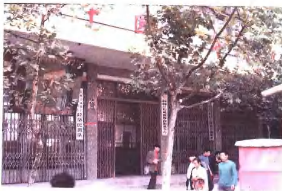
松桃苗族自治县工商银行办公楼
