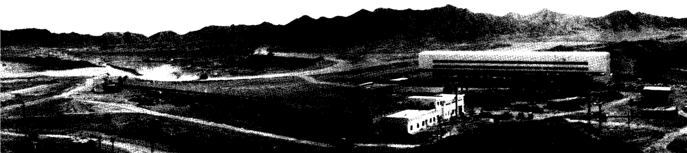
露天采场基建剥离及其辅助设施全景。
