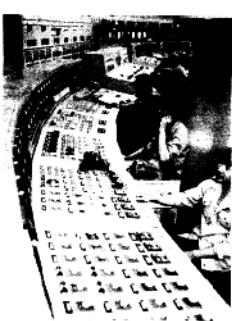
山东龙口发电厂 该厂是我国第一座由中央和地方集资兴建的大型坑口电厂。图为龙口发电厂主控制室
