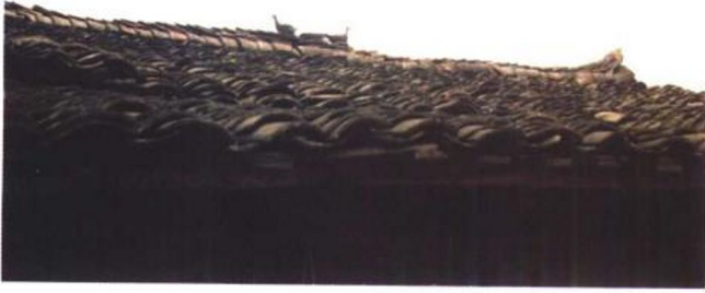
瑶麓旧宅屋顶上的石鸟
