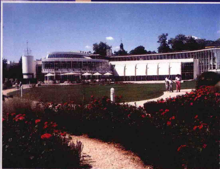
die Kongresshalle in Coburg
