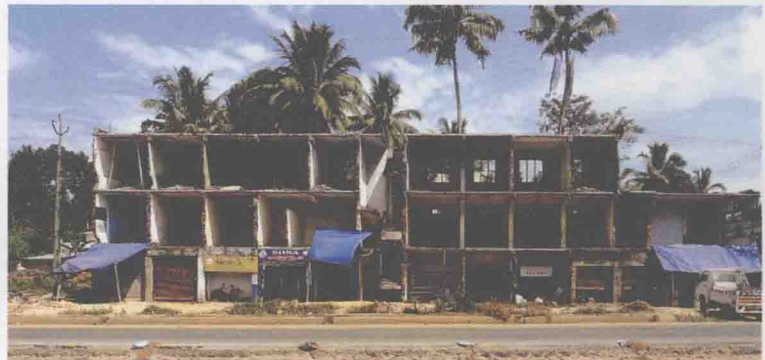
Recorte de edificio para ampliación de carretera Building cut out for road widening Thrissur, Kerala, India
