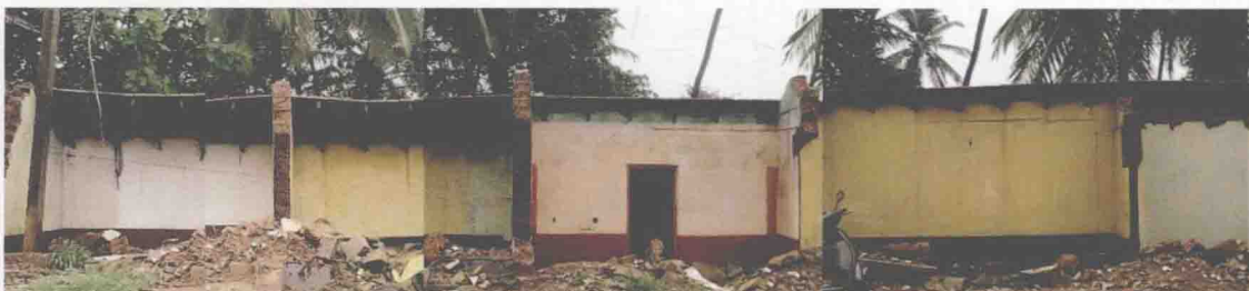
Recorte de edificio para ampliación de carretera Building cut for road widening Mangalore, Karnataka, India
