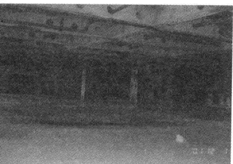
(d) Large deflection in the floor slab
