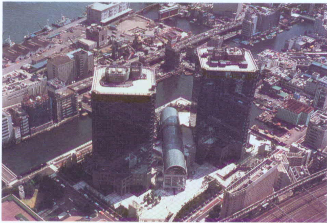
Overview from the air 空撮による全景 写真提供/清水建設
