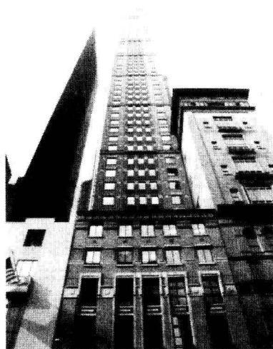
图 2.1.3-3 纽约卡内基大楼
