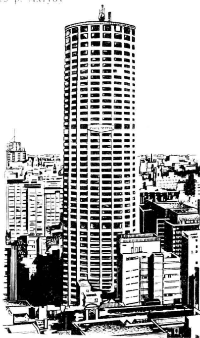
Рис. 1.5. Высотное здание из железобетона на легких заполнителях в г. Сиднее (Австралия)
