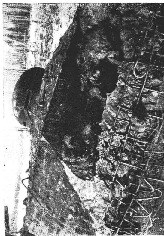
Долговременное огневое сооружение: 1, 2. Общий вид долговременного огнестрельного сооружения. 3. Один из разрушенных ДОС на «линии Маннергейма». 4. Разрушенный бронеколпак,
