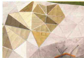
ACXT, Galindez slope, Bilbao.
