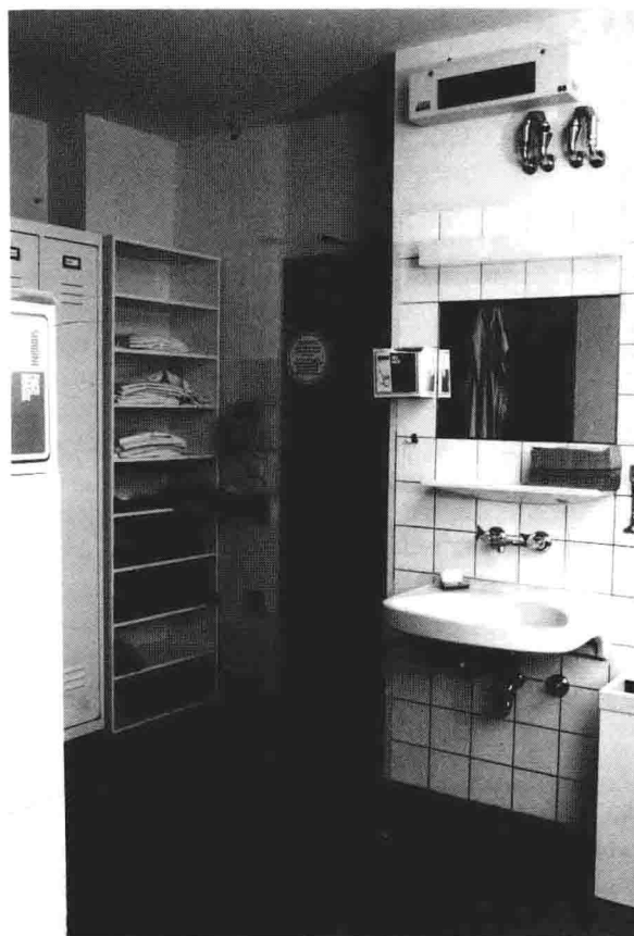
Abb. I. 4. Zugangstür aus der Personalumkleidezone in den „sterilen Bereich“ des Operationsraums. Die Tür läßt sich nur durch Betätigen des Desinfektionsspenders öffnen
