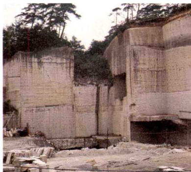
宇都宮市 大谷石の採石場。大谷石は第三紀緑色凝灰岩で、ここでは厚さ300mに達するところもある。採石によってできた空洞で落盤が起き、人身事故を起こすこともある
