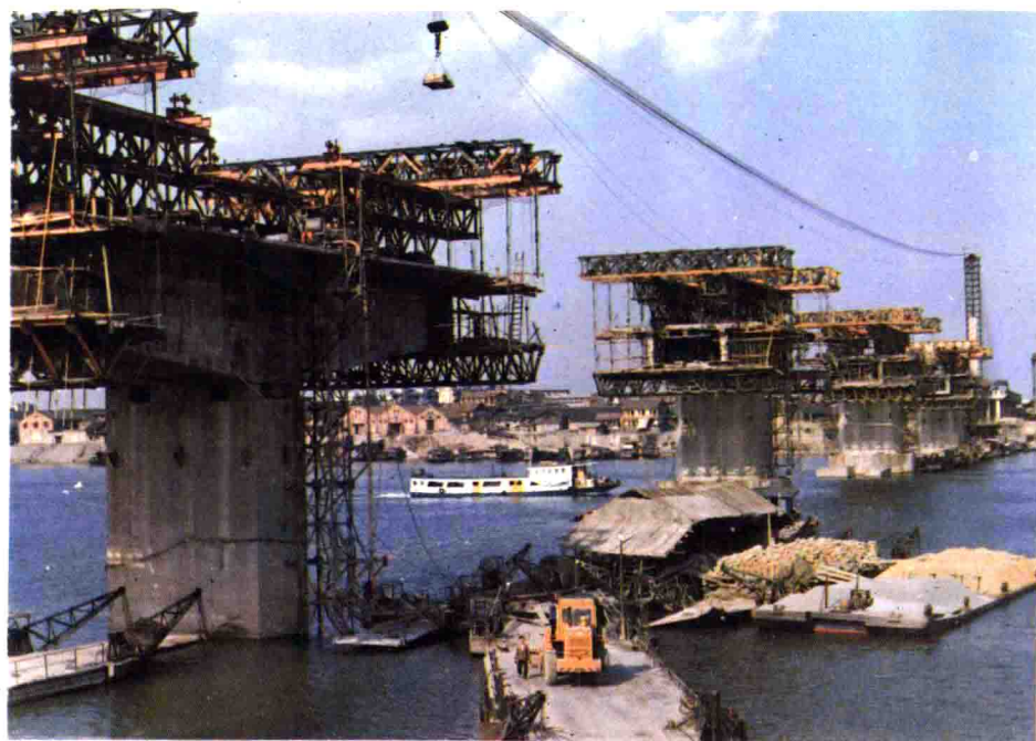
挂兰悬浇箱梁
