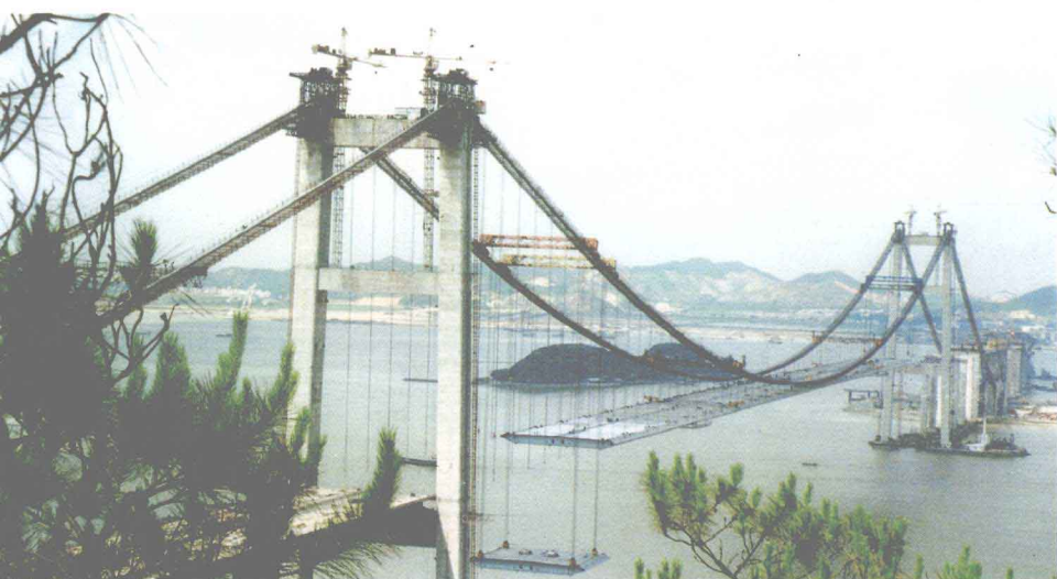
彩图8 卷扬式跨缆起重机提升钢箱梁
