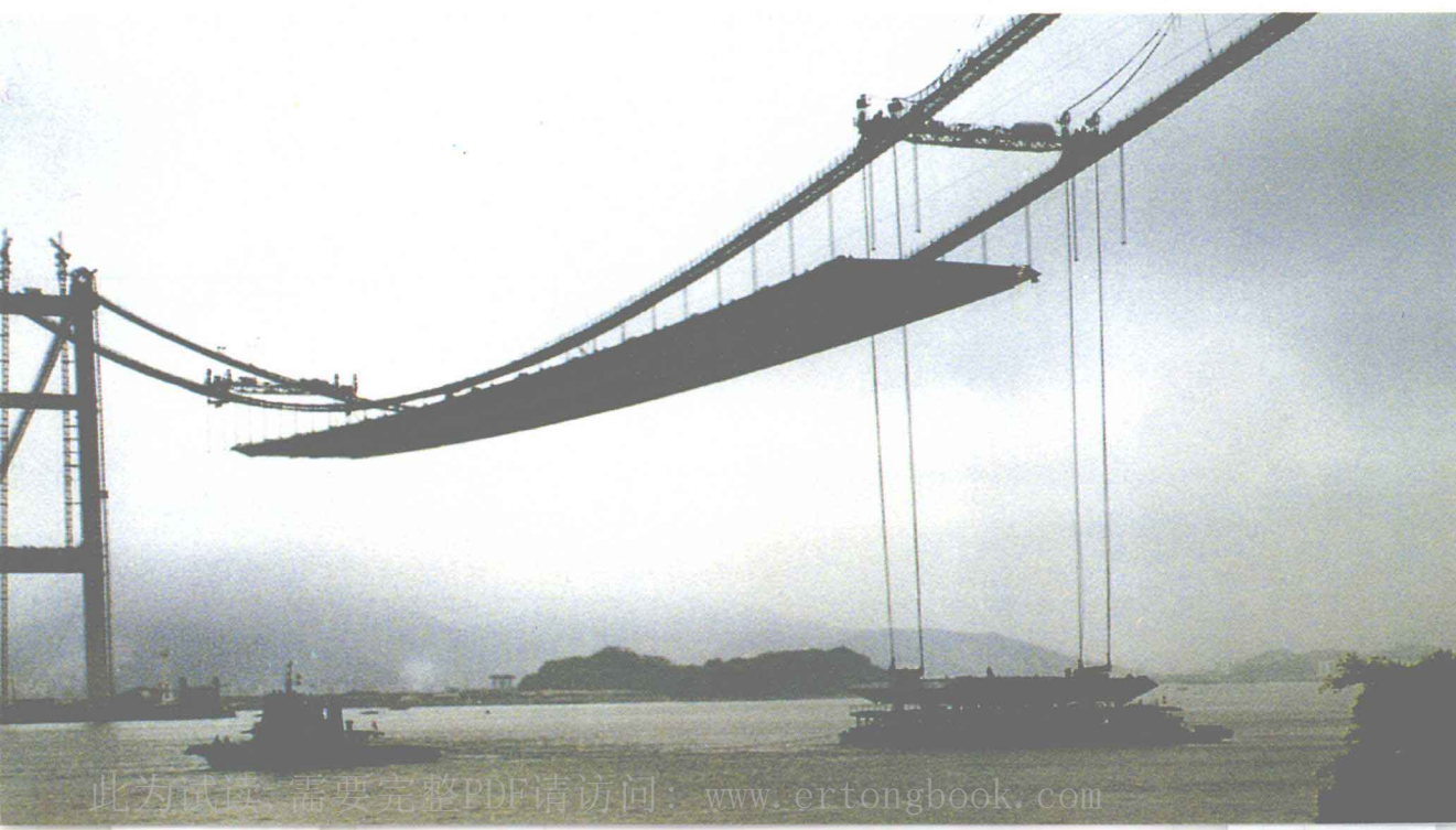
彩图 6 液压提升跨缆 起重机提升钢箱梁
