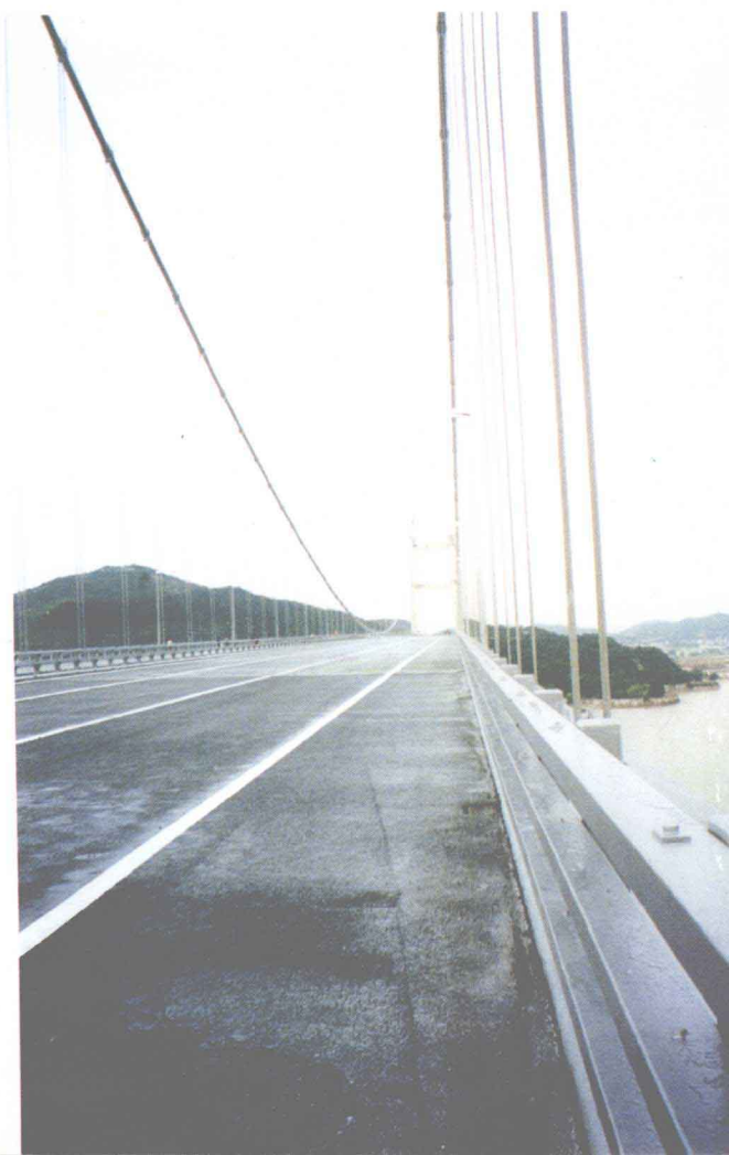
彩图 11 已架设好的虎 门大桥
