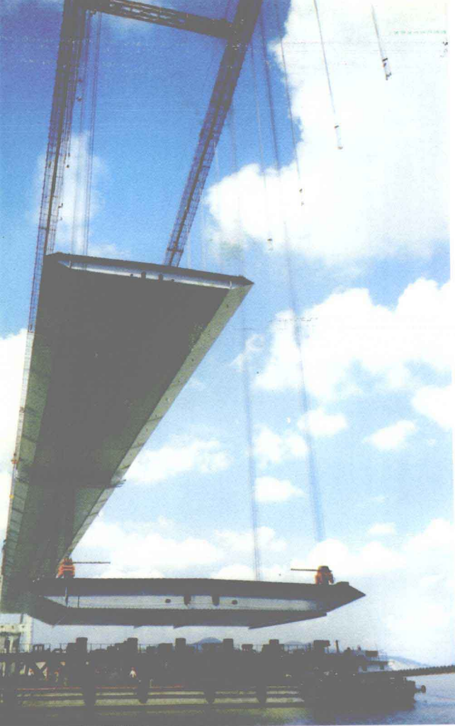
彩图 10 虎门大桥卷扬式跨缆起重 机吊装钢箱梁
