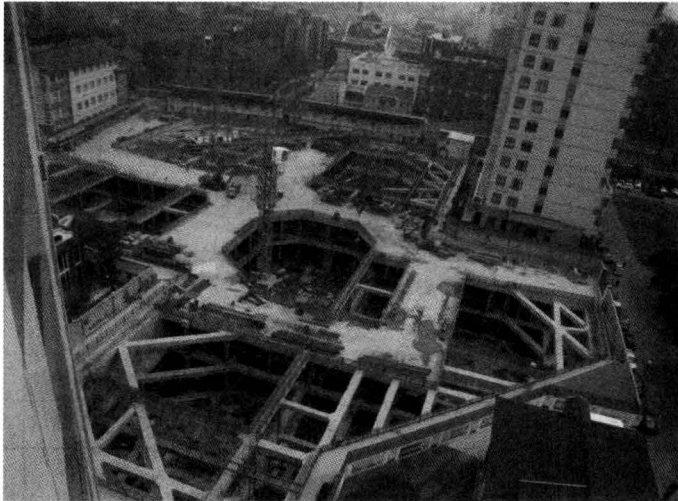
图 1 基坑施工现场照片
