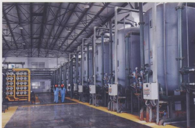
循环冷却水排污处理
