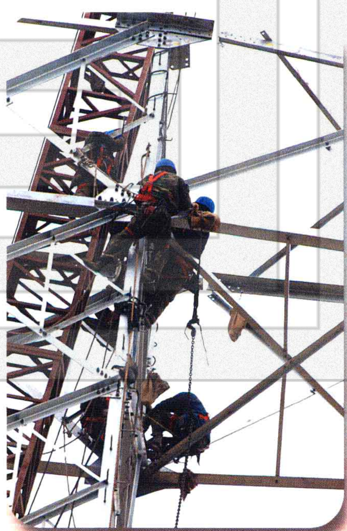
750 千伏铁塔组立
