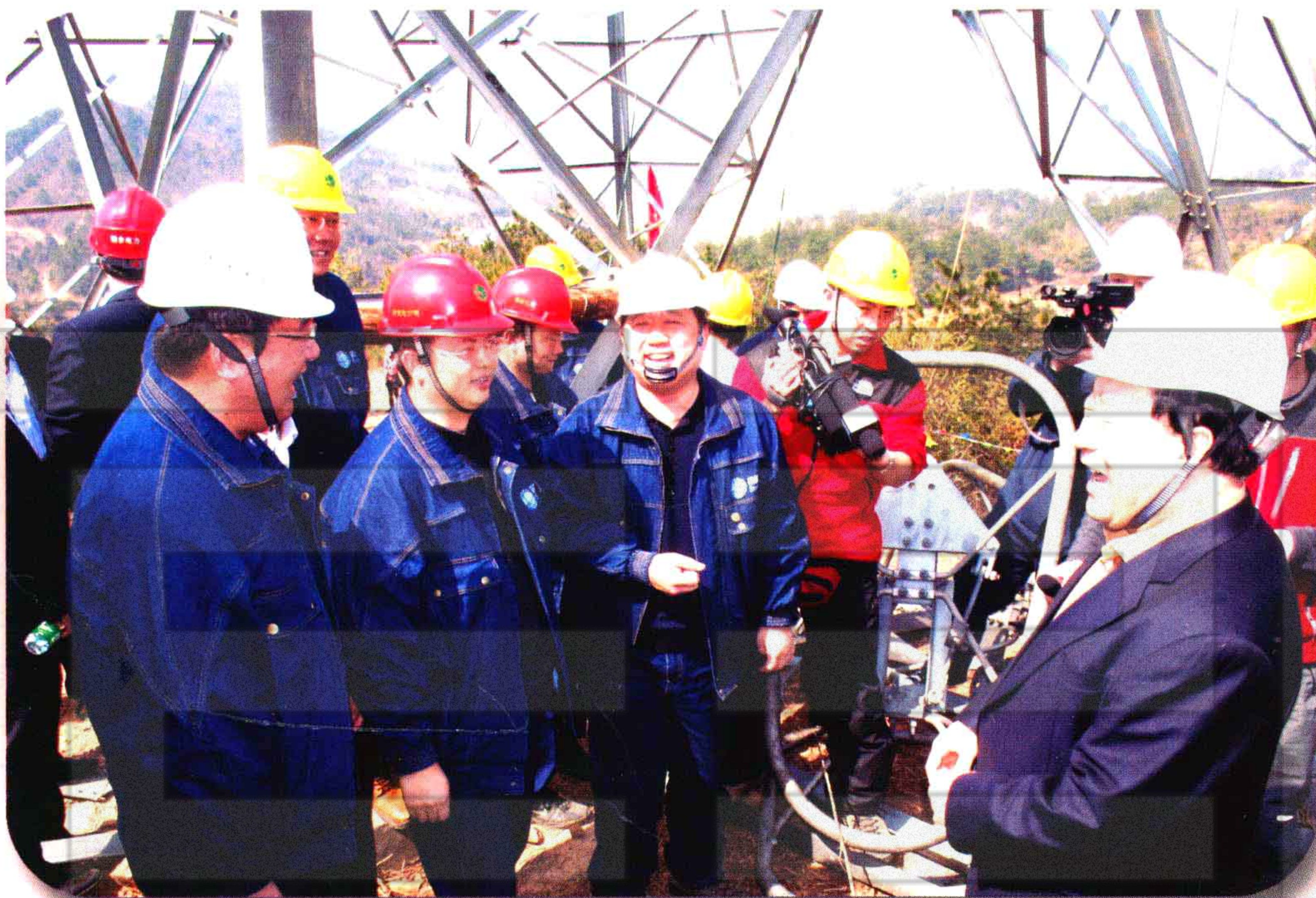
国家电网公司党组书记、总经理刘振亚视察湖南抗冰抢险施工现场
