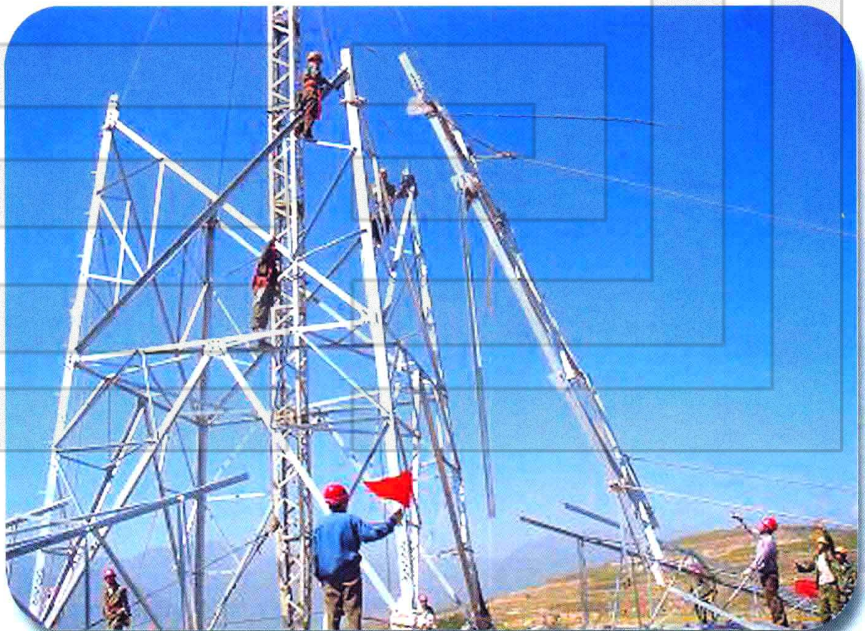
输电线路铁塔组立
