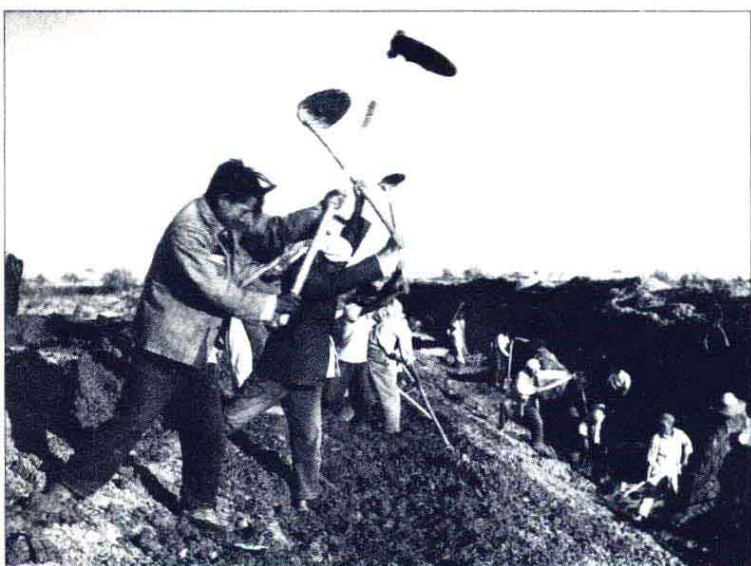
开挖西岸大渠(1958年)
