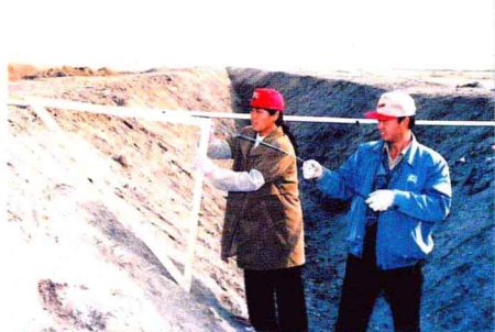
1998年，团开发办人员在河滩 检测二支渠工程质量
