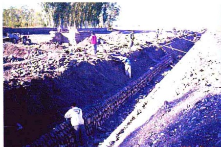
施工人员正在抢修被洪水冲坏的洪海西干渠
