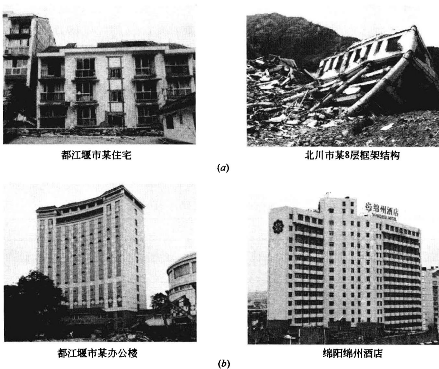
图 2.1 汶川地震震害照片 (a) 框架结构；(b) 框架-剪力墙结构
