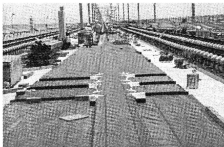
图 1-5 施工完成后的纵横向凸台
