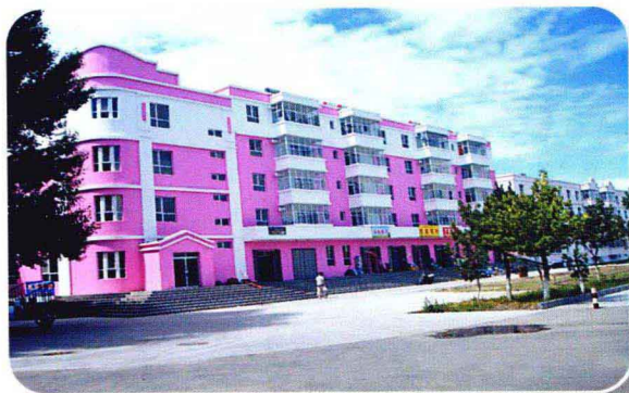
在实施危旧住房改造工程的基础上,一八五团又开始了经济适用房建设,图为2007年建成的居民楼
