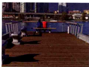
东南佛斯港湾滨水公园一期工程
