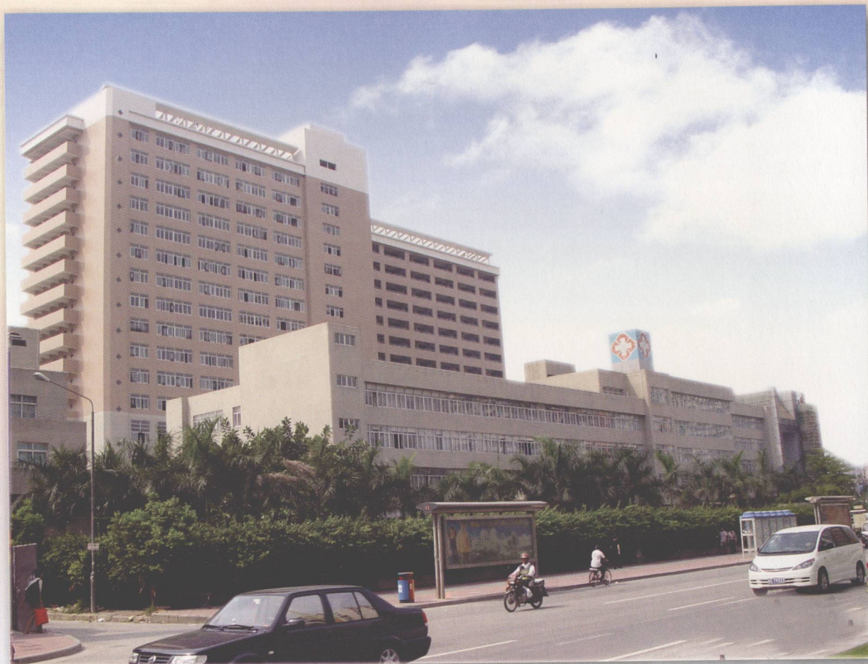
新医院建设工程（虎门大道）
