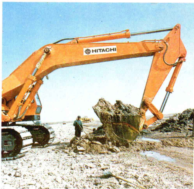
◀察尔汗钾肥厂开挖新盐池
