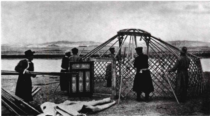
圆顶帐篷或蒙古包是来自中亚的人造建筑，其独立的组件由专门人员制造。它将圆形墙结构与屋顶内的张压圈相结合。这种建筑通常是拆除后运输，但它具备足够的强度，短距离也可以直接运输。
