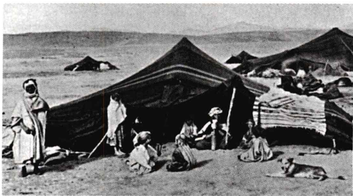
北非贝多因人的帐篷依然被用作各种不同的形式，但实质上它属于一种受压杆悬挂的张拉膜。这种帐篷轻质且可以移动，并能适应严寒气候，应付极端环境的变化。
