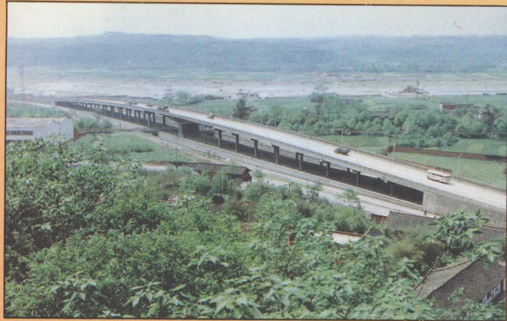
◀ 绵阳公铁立交桥
