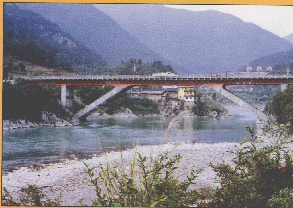
▼ 北川通口黄江大桥
