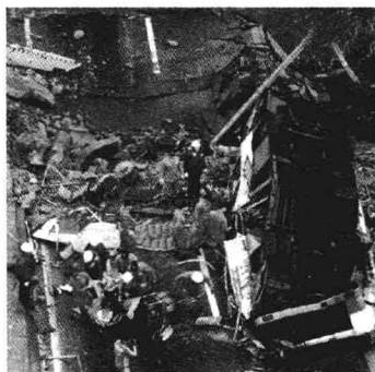
图 1—12 韩国首尔圣水大桥坍塌
