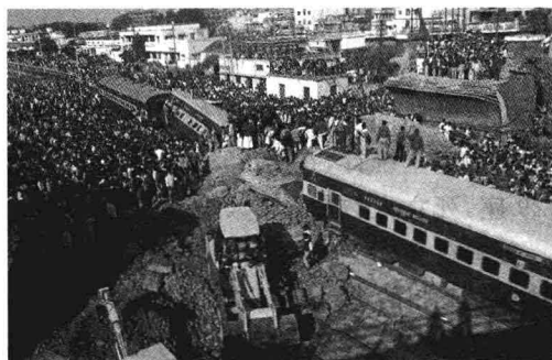
图 1—15 印度帕戈尔布尔火车站附近一座旧桥坍塌
