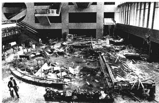
图 1—10 美国海厄特—里根西饭店高架人行桥断裂
